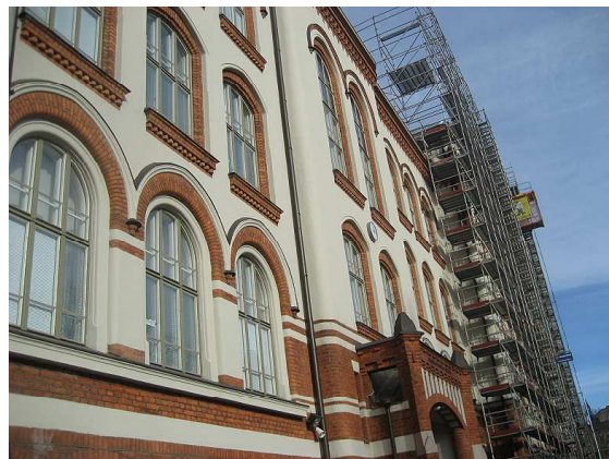
Die Außenfassade des Gymnasiums
