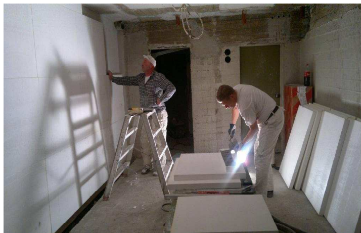
Verlegen der Kalziumsilikatplatten „epatherm“ im Gymnasium
