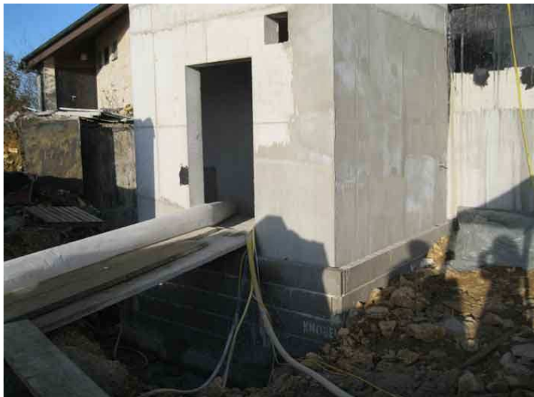
Außenansicht: Im erdberührten Bereich wurde der Neubau mit MineralDicht® abgedichtet.
