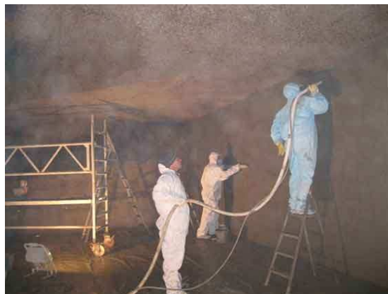
Der Nassspritzmörtel wird auf die Kammerwände aufgebracht. Bilder: epasit
