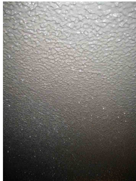
Spritzrauh verputzt: Die Decke des Behälters.
