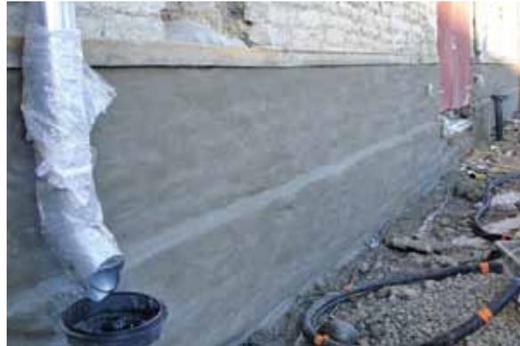
Der Sperrputz wurde korrekt bis zur Bodenplatte aufgezogen
