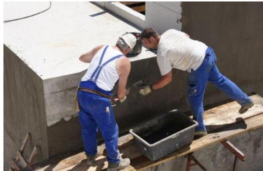
Bild 4: Der Sperrputz wird mit der Traufel auf die Außenwände im erdberührenden Bereich aufgetragen.
