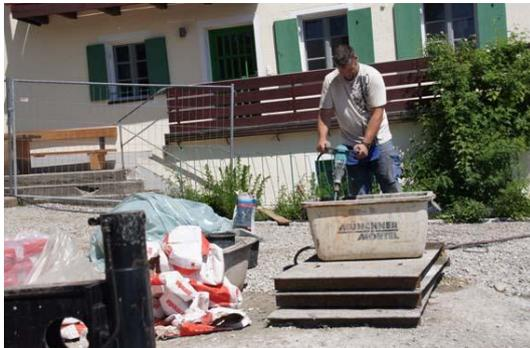
Bild 3: epasit MineralDicht sperr wird mit Wasser knollenfrei angerührt.
