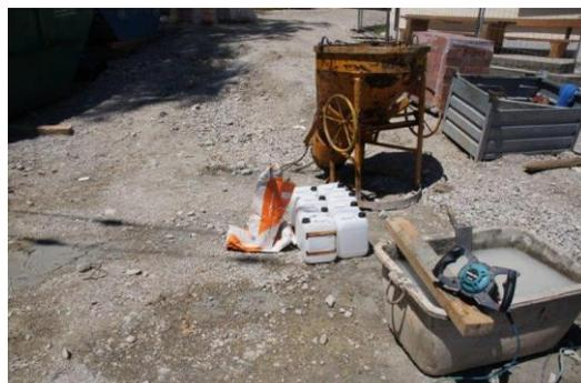
Bild 2: Wegen des kritischen Untergrunds wird der Spritzbewurf mit epasit Haftemulsion und Wasser angemacht.
