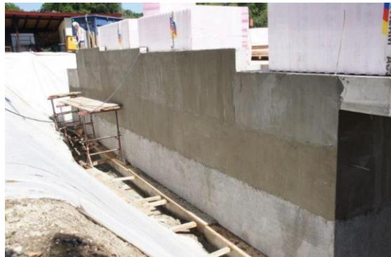
Bild 6: Die Kellerwände sind zum Großteil mit Sperrputz überzogen.
