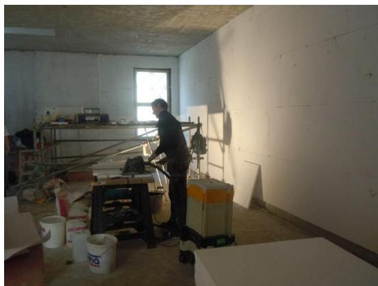
Bild 4: epatherm-Platten werden in Streifen geschnitten zur Dämmung der gebogenen Wand.
