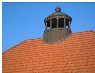
Bild 6: Das Dach wurde mit Biberschwanz-Ziegeln nach historischem Vorbild in einer Kronendeckung erstellt.
