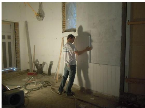
Bild 1: Ein Verarbeiter der Firma Lehmann bringt eine *epatherm*-Dämmplatte an.
