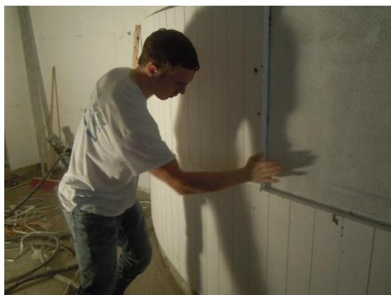
Bild 2: Die gebogene Wand wird gedämmt.
