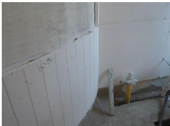
Bild 3: Der untere Wandteil ist vollflächig verklebt.
