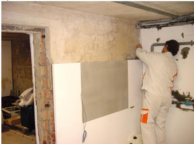
Bild 1: Der Keller wurde mit epatherm Dämm- und Heizplatten ausgebaut.
