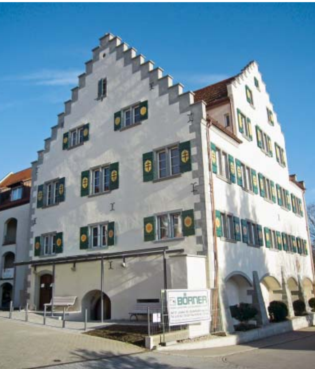
Der denkmalgeschützte Waldseer Hof nach der Sanierung: dank der Innendämmung konnte die ursprüngliche Fassade wiederhergestellt werden.
