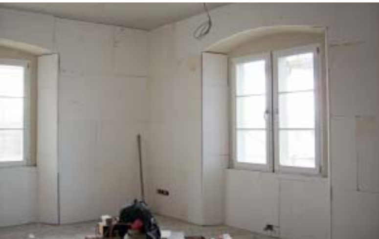
Die Innenwände und Decken wurden mit Calciumsilikatplatten gedämmt, wodurch die Energiekosten gesenkt und ein gesundes Raumklima geschaffen werden konnte.
