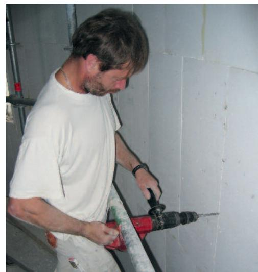
12 Um die Rundung der Wand zu erfassen, wurden die Platten in kleinere Einheiten gesägt.
