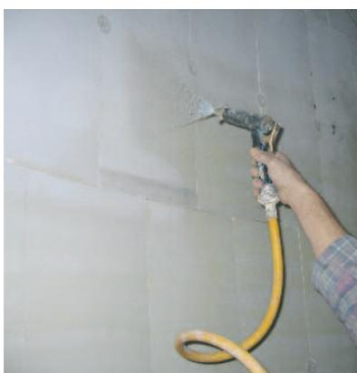
14 Da die Calciumsilikat-Platten sehr stark saugfähig sind, werden sie grundiert, um ein Aufbrennen des Klebers und des Putzes zu verhindern.
