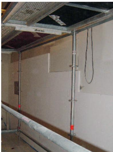
4 An den Außenwänden werden Calciumsilikat-Platten verlegt.
