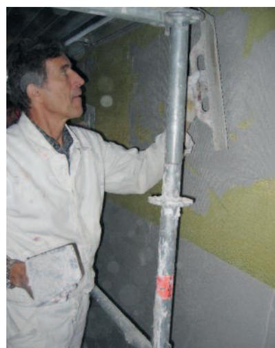
15 In den dünn-schichtigen Putz wird voll-flächig ein Gewebe eingelegt.
