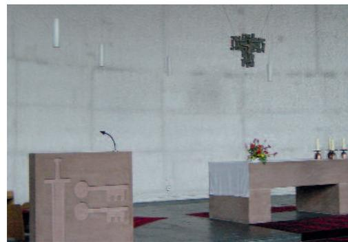
9 An den Außenwänden zeichneten sich deutlich die Fugen der Holzwolle-Leichtbauplatten ab.
